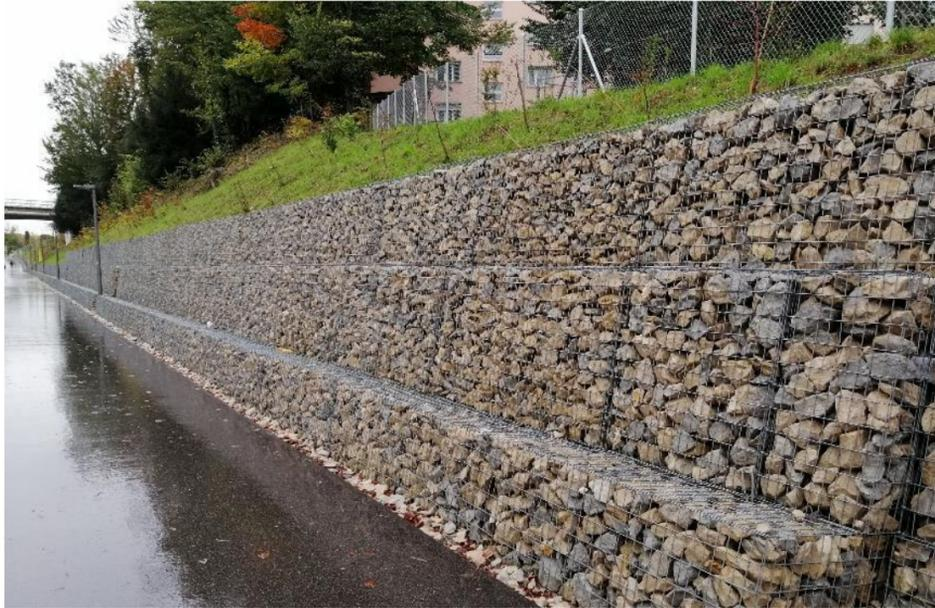
Il s'agit de paniers métalliques **pré-remplis en carrières**. Les pierres sont vibro-compactées pour un remplissage parfait et une densité optimale.
